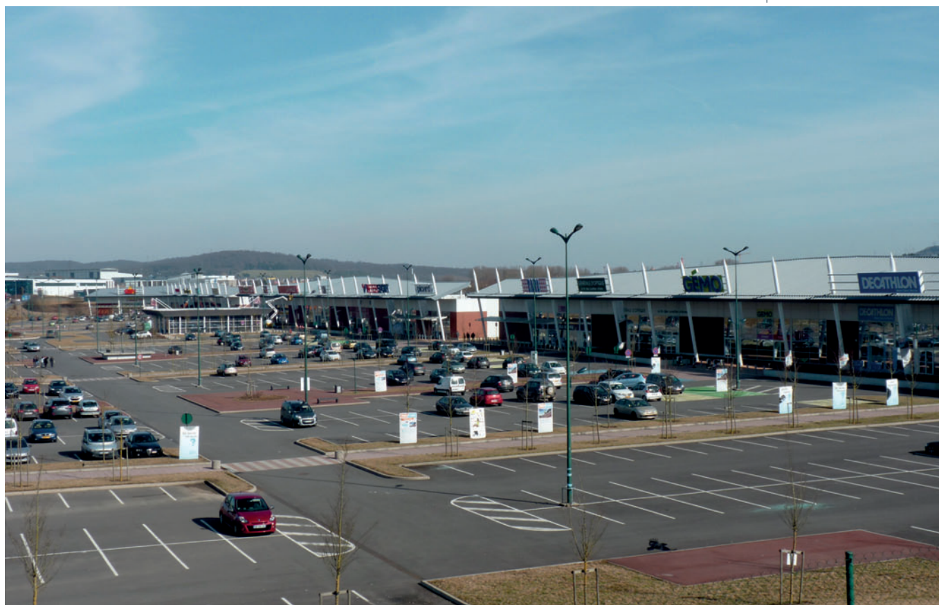
Zone commerciale Pôle Europe à Mont-Saint-Martin
